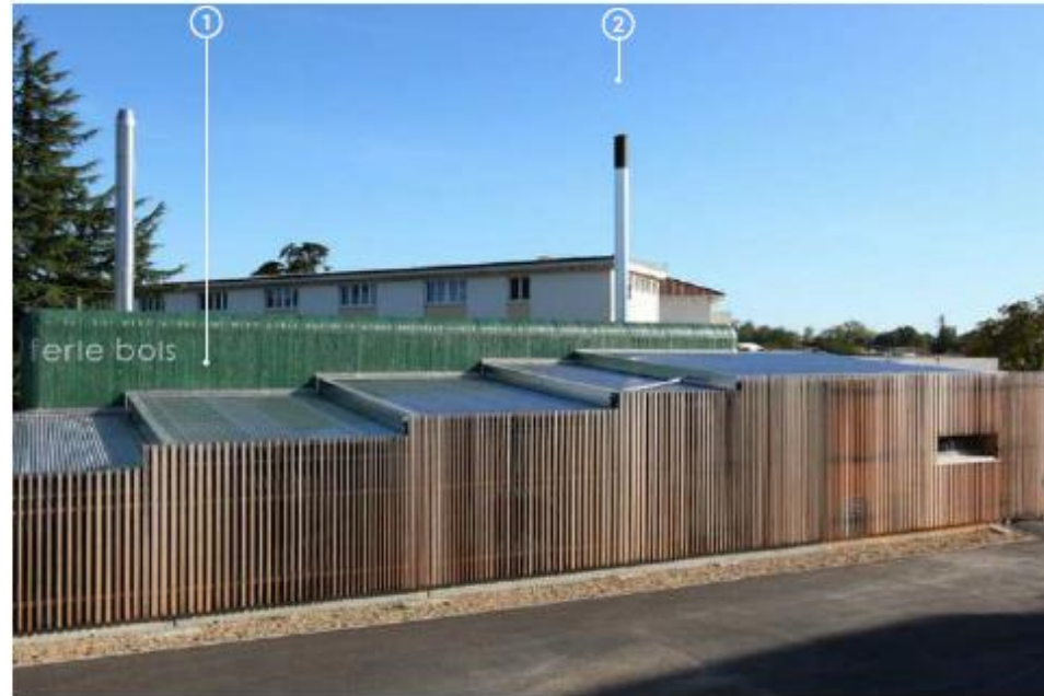
Chaufferie bois de l'hôpital de Lesparre, Médoc, Gironde © Architectes-pour-tous
